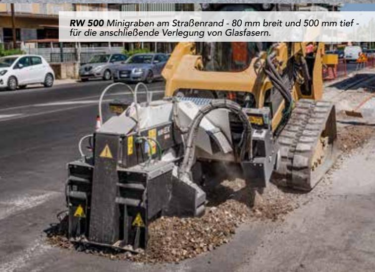
**RW 500** Minigraben am Straßenrand - 80 mm breit und 500 mm tief - für die anschließende Verlegung von Glasfasern.
